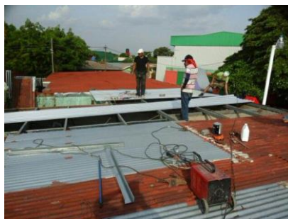
Das Dach wird ausgetauscht
